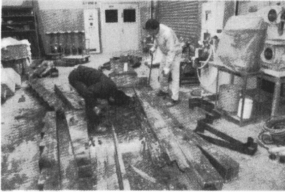
写真-4 解体の様子
