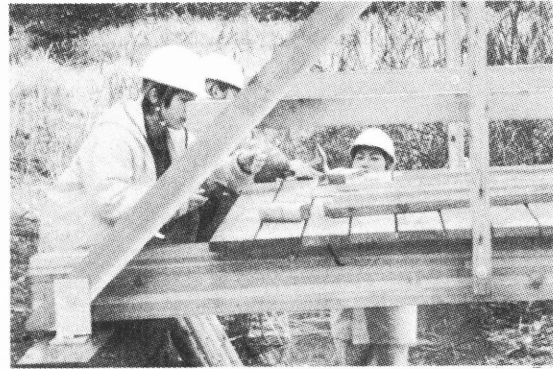
写真8 床板の打ち付け作業
