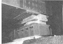
約40年経過 塗り替え時に無塗装とした。支承交換(亀裂対策)
