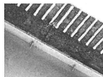
(4) グレーチング床版の腐食
