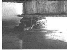
アーモローラ支承の腐食
