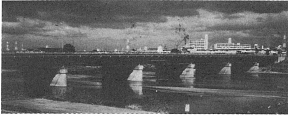
7径間連続ゲルバー桁
