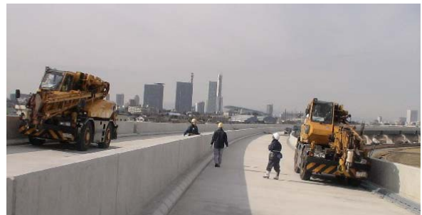
写真 4A.2.1 荷重車試験状況写真(ケース B)
