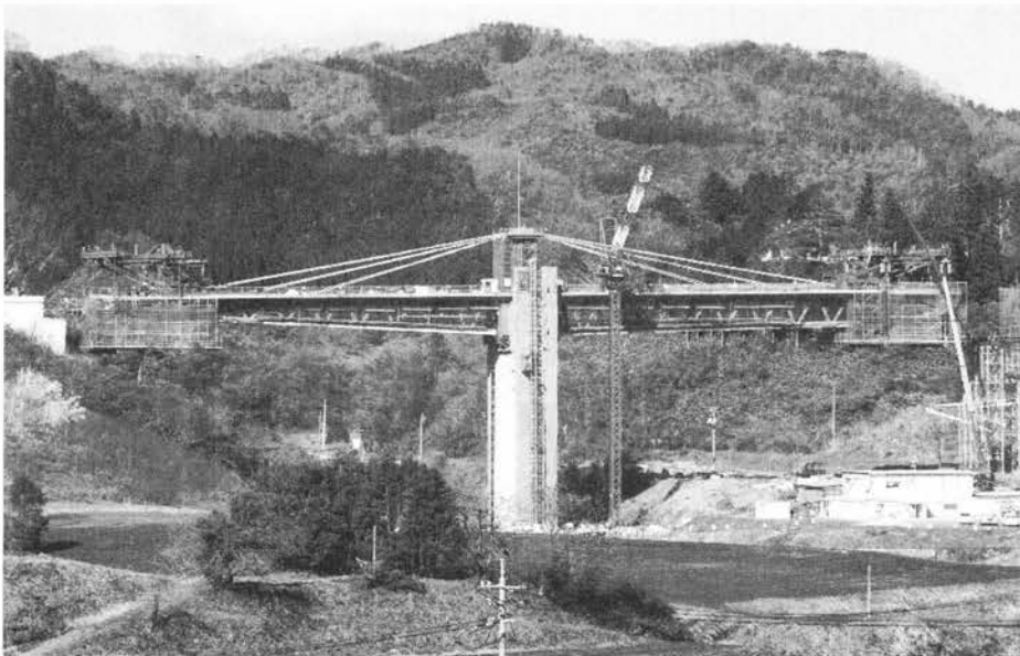
写真-7.2.5 志津見大橋の張出し架設状況
