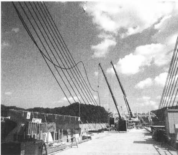
写真-7.2.18 ケーブルの架設状況(栗東橋)
