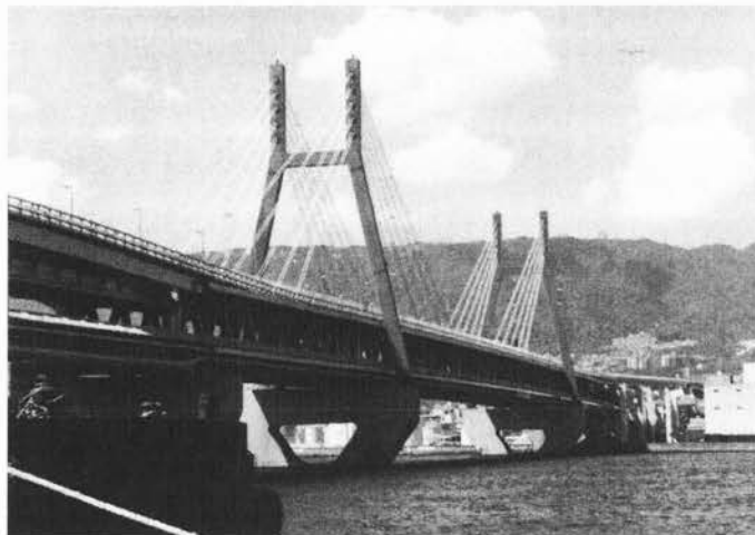
六甲大橋 (神戸市)
