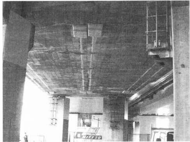
写真-7.2.38 調布高架橋(都計213橋)
