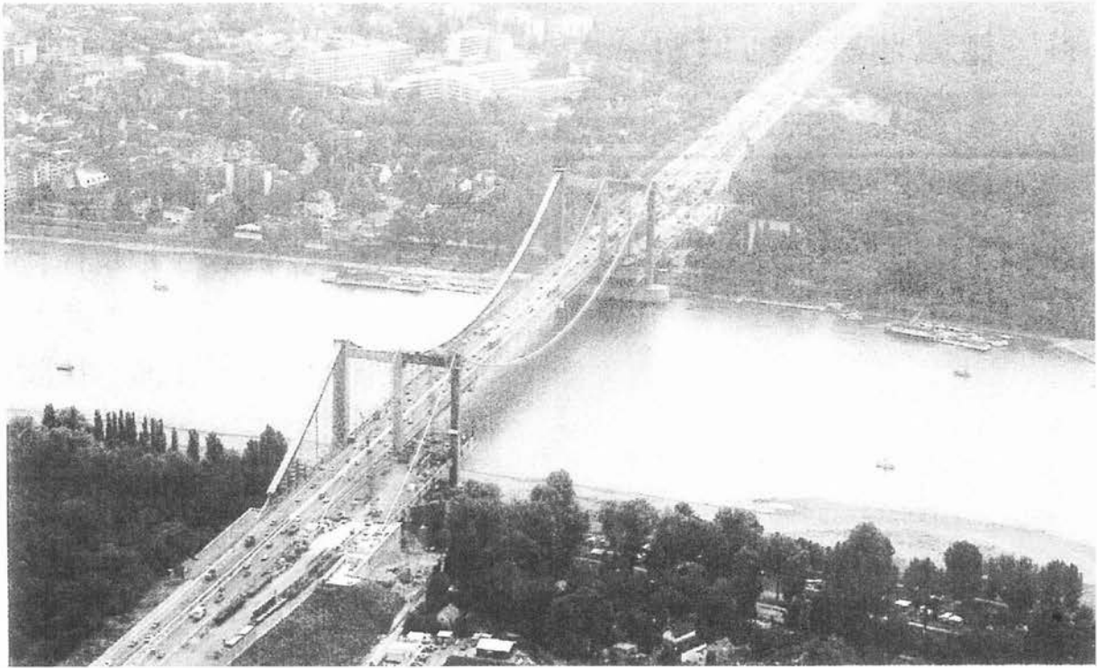
写真-7.1.2 ローデンキルヘン橋の拡幅施工中の状況
