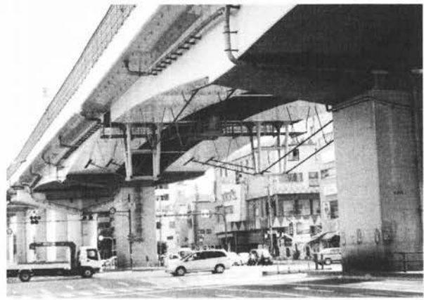
(b) 補強後 (中央ヒンジ部)
