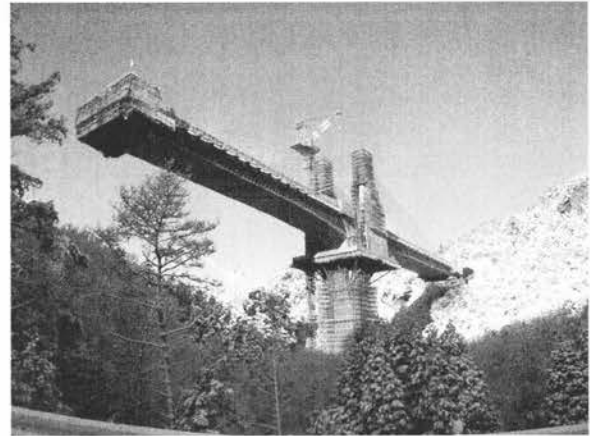
写真-7.2.14 栗東橋の張出し施工の状況
