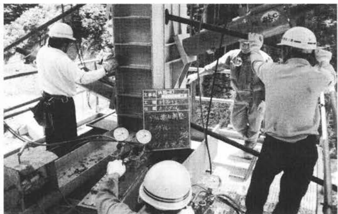
写真-7.2.3 ピロン柱と斜吊りケーブル
