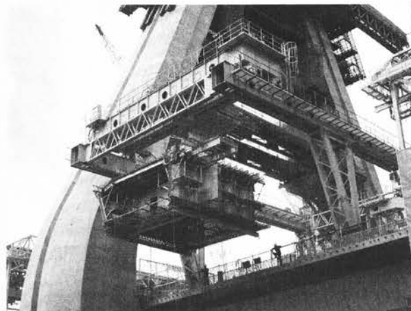
写真-7.2.25 プレファブユニットの吊上げ
