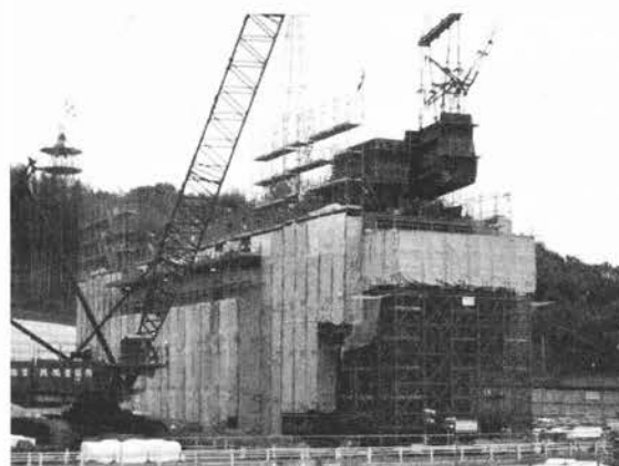
写真-7.2.28 鋼殻の施工状況
