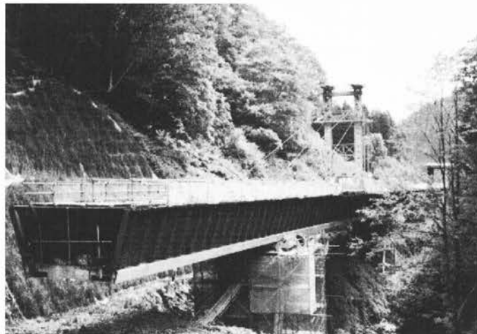
写真-7.2.2 斜吊り併用押し出し架設の状況
