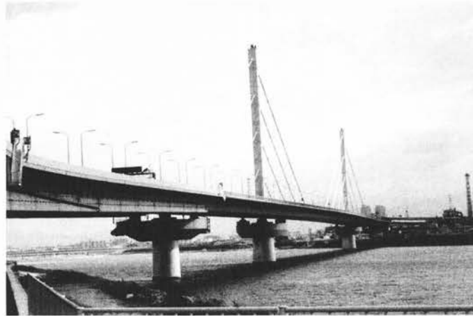
大和川橋 (大阪市)
