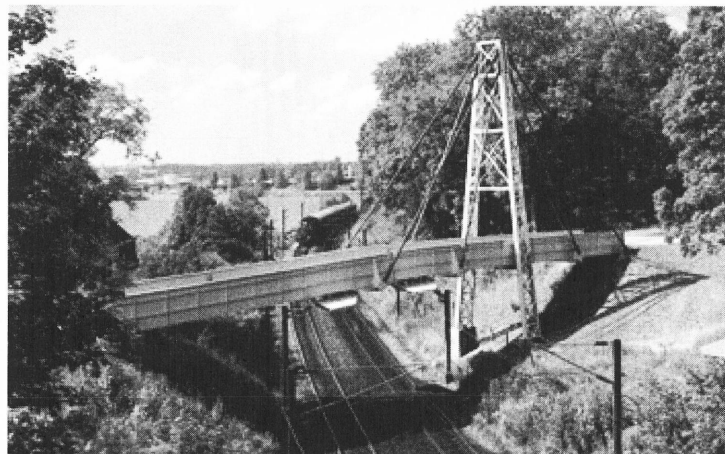
写真-6.3.4 コルディング橋の全景
