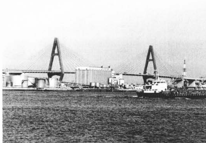
名港東大橋（名古屋市）
