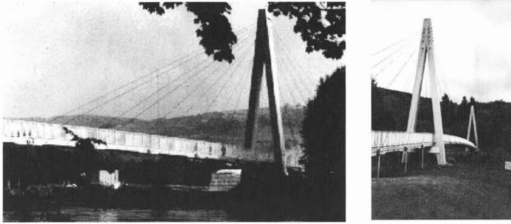
写真-6.3.1 アバフェルディー(Aberfeldy)歩道橋の全景
