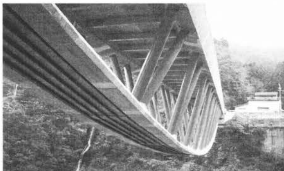
(a) 完成状況(下床版)
