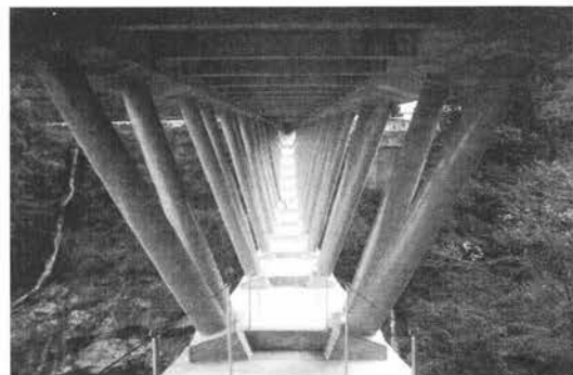
(b) 完成状況(鋼斜材)
