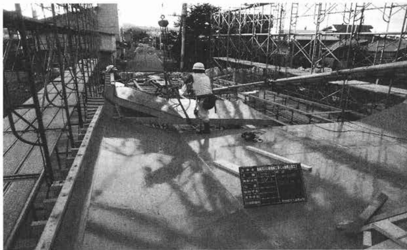
写真-5.2.27 型枠組立(望景橋)
