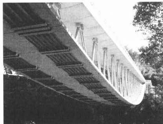
写真-5.2.9 ケーブルの配置状況(のぞみ橋)
