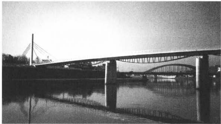
写真-5.2.17 あゆみ橋の完成写真
