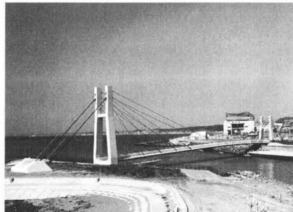
写真-5.2.15 なぎさブリッジ
