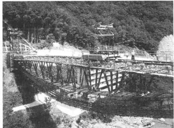
写真-5.2.3 補剛桁ユニットの架設(青雲橋)
