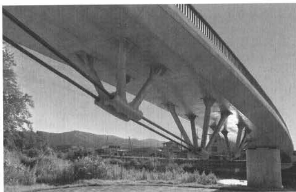
写真-5.2.22 ストラット接合状況(望景橋)
