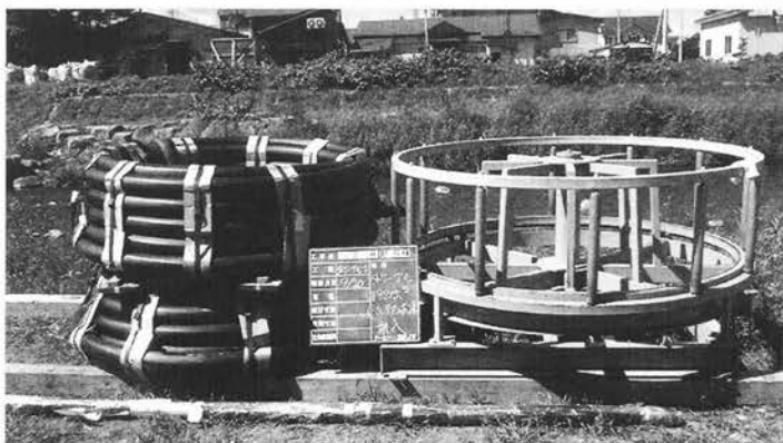
写真-5.2.24 巻かれたケーブル（望景橋）
