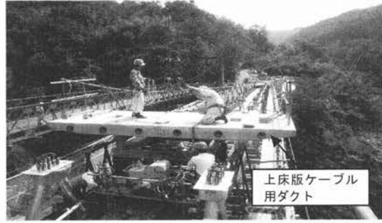
写真-5.2.13 上床版の架設(のぞみ橋)
