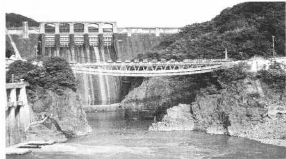
写真-5.2.14 上床版架設時の仮置き状況(のぞみ橋)
