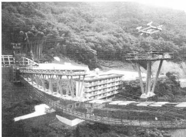
写真-5.2.2 斜材ユニットの架設(青雲橋)
