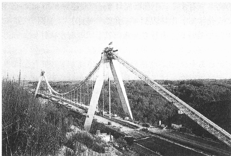
写真-3.1.8 シャヴァノン高架橋の施工時全景
