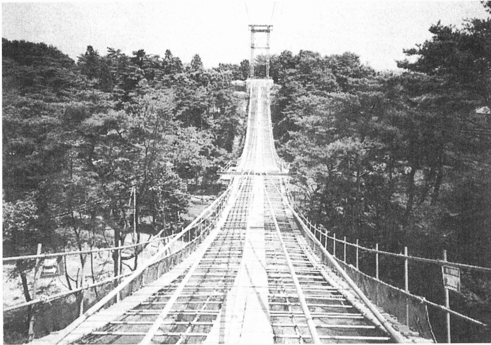
写真-3.1.15 アドベンチャーブリッジの主ケーブル架設
