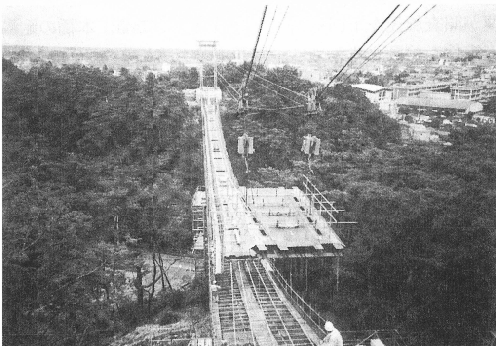
写真-3.1.16 アドベンチャーブリッジの鋼製主桁架設
