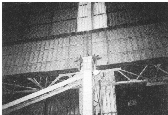
写真-3.2.1 波形鋼板ウェブを用いたクレーンの受梁の例(1976年に設置)
