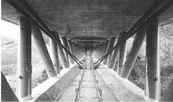
写真-3.2.22 外ケーブル配置状況の実例
