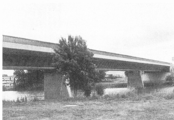
写真-3.2.2 波形鋼板ウェブを用いたコニャック橋(1986年に架設)
