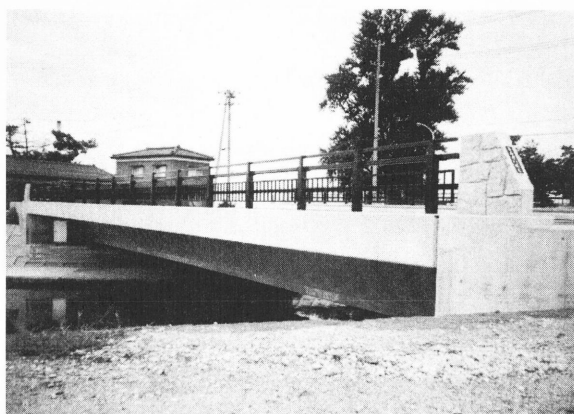
写真-3.2.3 新開橋(1993年に架設)
