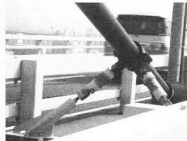
(b) ダンパーによる制振対策
