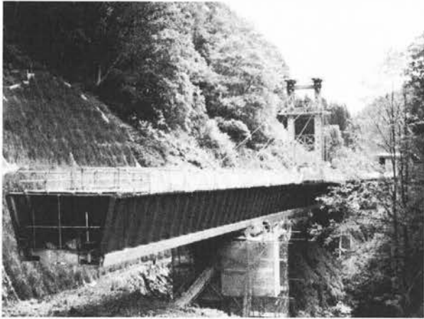
写真-2.5.8 手延べ斜吊り併用押し工法の架設時全景
