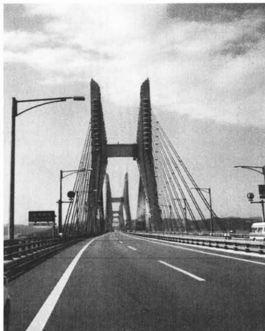
図-2.3.12 鋼殻構造の例
