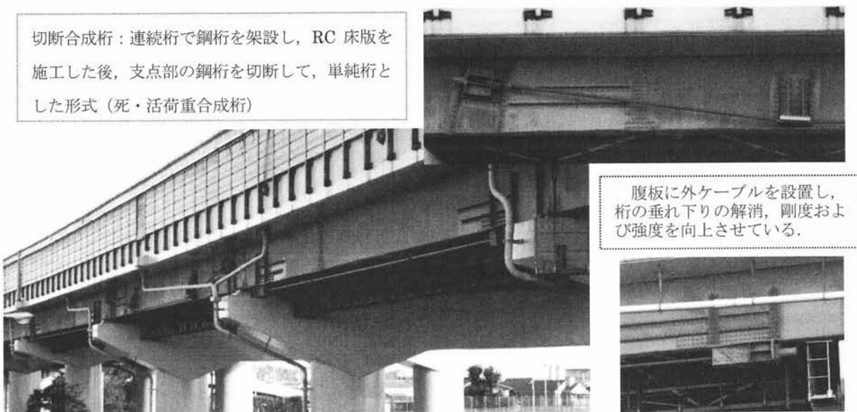
(a) 3径間切断合成桁橋
