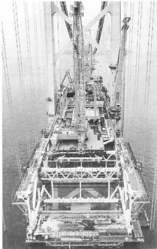
図-2.5.2 補剛桁架設単位による工法の分類
