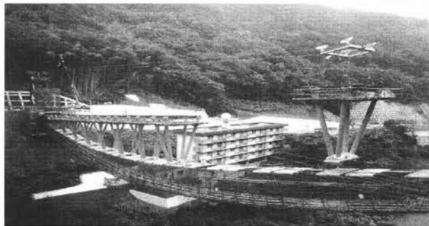
写真-2.5.10 吊り床版橋の斜材ユニットの架設状況の例
