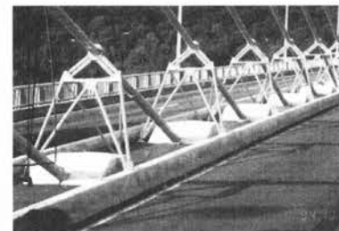
(d) 端部拘束による制振対策
