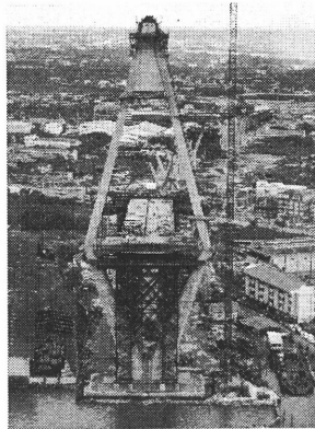
図一七 主塔施工状況
