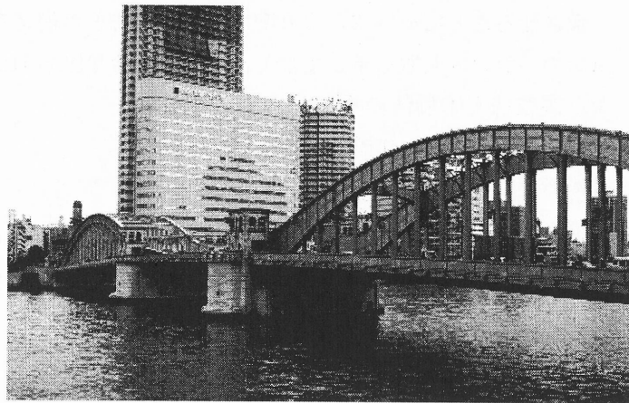
写真 - 2 勝国橋の全景
