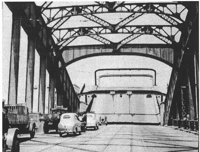
写真 - 1 跳開した勝鬨橋の路面状況
