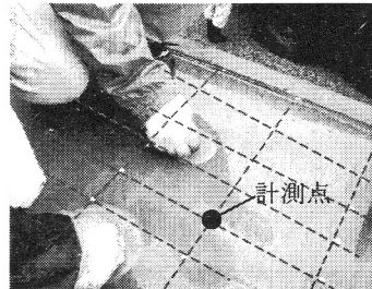
写真-2 空気孔処理状況と充填検査計測点
