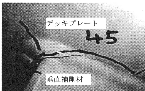
写真-4 モード③-b: 溶接ビードの垂直補剛材側止端を起点として、溶接ビードとデッキプレートに進展するき裂
