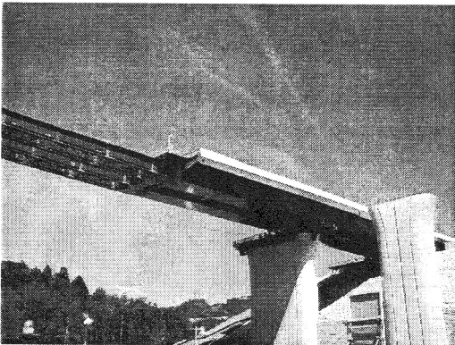
(b) 送り出し架設の補強材
