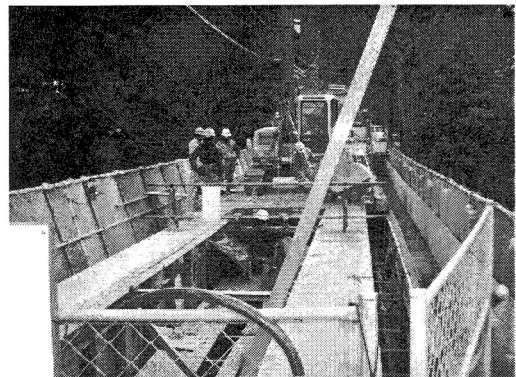
写真1 床版撤去状況
