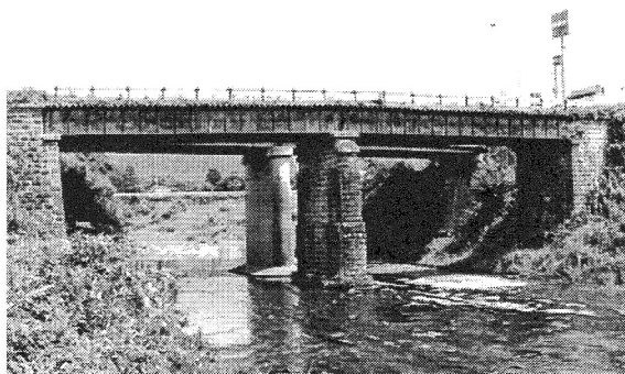
写真-1 明治橋全景
