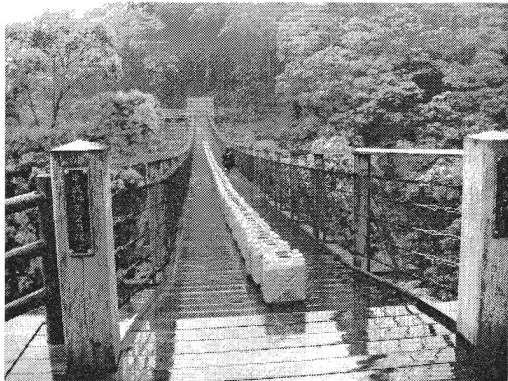
写真-2 静的載荷試験 （半スパン幅員中央載荷）
