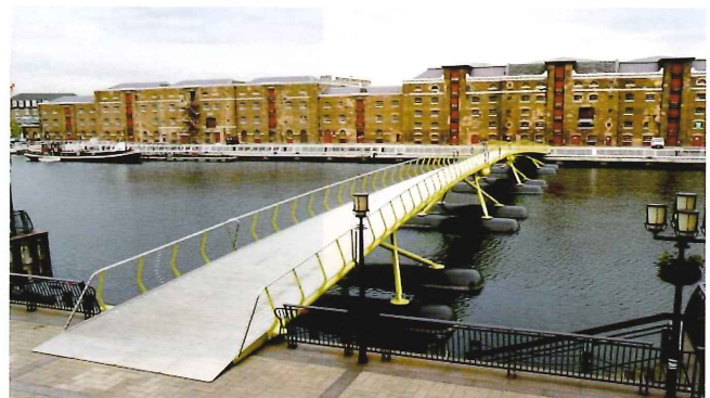
No. 11 West India Quay 歩道橋 17)
