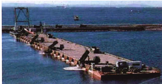
図-付 1.1.5 浮体橋を用いた埋立用土砂の運搬 5)
