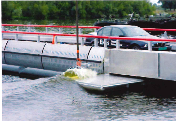
図-付 1.1.4 アルミニウム製の浮体を用いたオランダの浮体橋 4)
