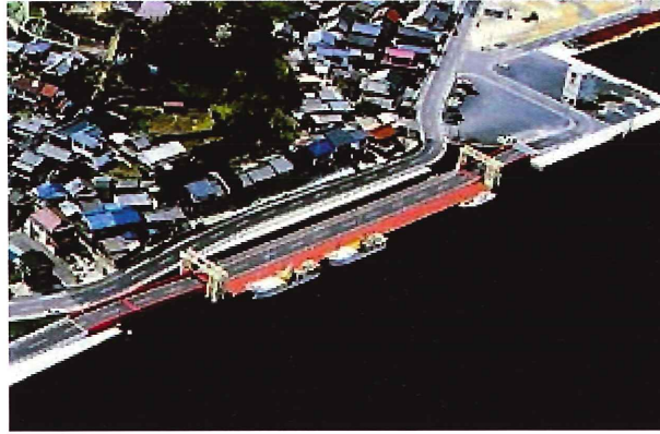
No. 12 名護屋漁港 浮体式係船岸 11)
