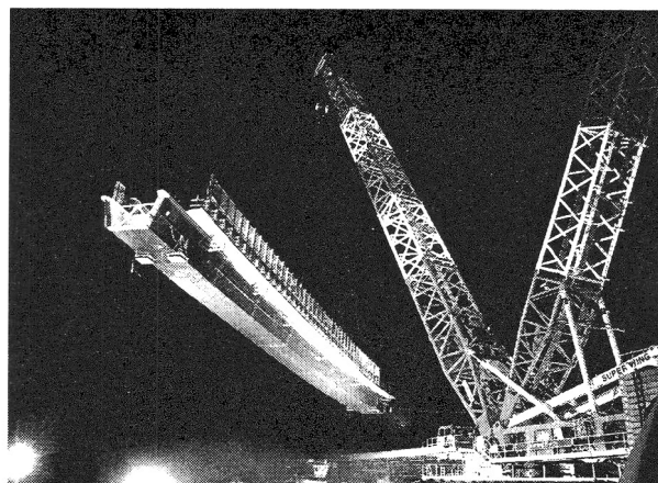
写真-7 一括架設（吊上げ時）
