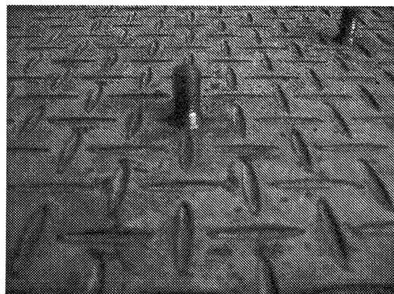
写真-1 コンクリート側接触面の状況, 床版 (B)
