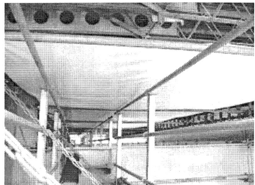
写真-6 床版下面状況
