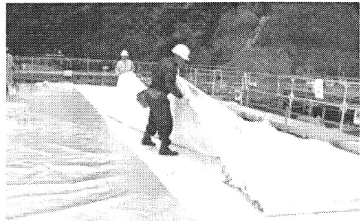
写真-4 遮光シート敷設状況
