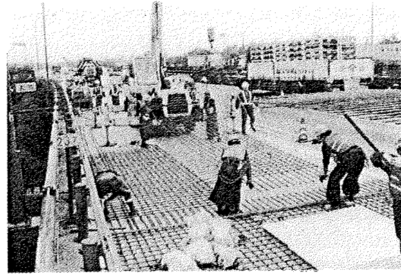
写真-2.4.3 鉄筋工（鉄筋補強上面増厚工法の場合）
