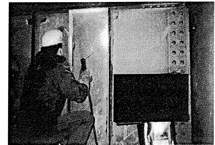
写真-2.3.1 横桁（既設）への補強材設置状況
