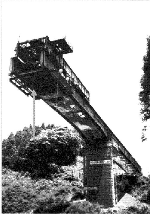
写真 4 今別府川橋架設中
