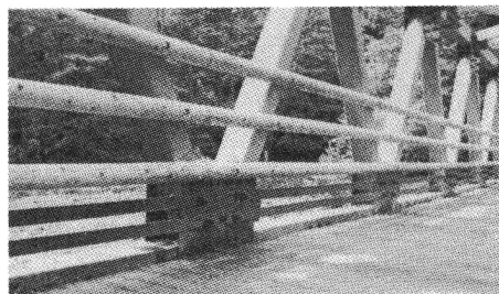
写真5 フラットバーの留め付け状況
