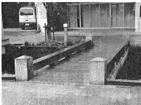
写真-1 小規模歩道橋の例
