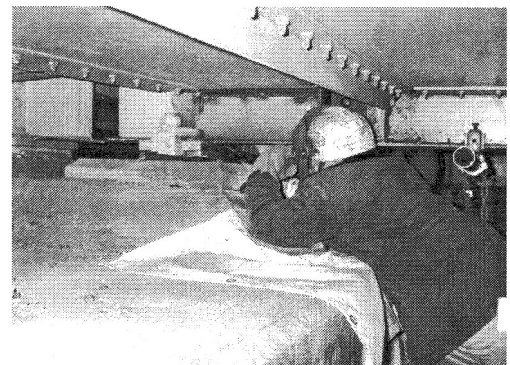
写真—1 溶接による補修状況
