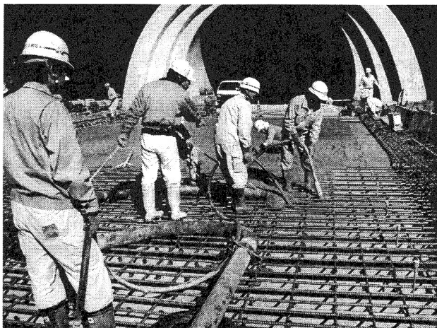
図-14 コンクリートの打設状況
