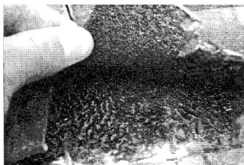
写真8 膨れ部分の開削状況
