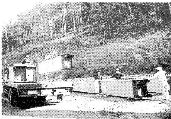
写真-3 主桁の運搬
