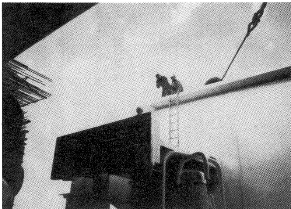
図-12. 11. 2 鋼板による接続の事例（Nordhordland 橋）
