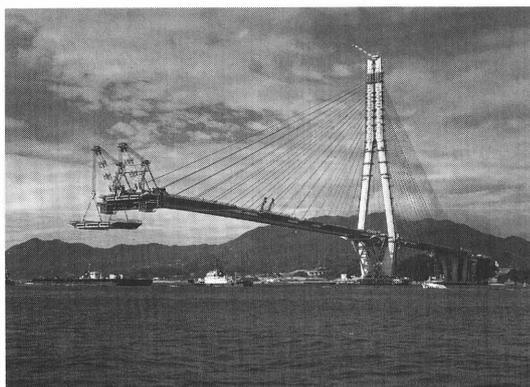
写真 A5.2.1 2層式ジブクレーン
