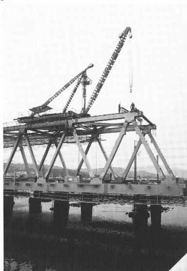
写真 A5.2.2 三脚式ジブクレーン
