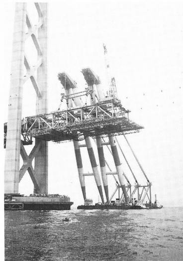
写真 A5.4.4 非自航式固定ジブ浮きクレーン
