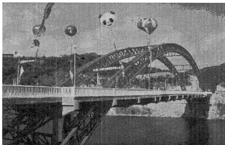
写真-3.2.3.1 石潭溪大橋の外観 1)
