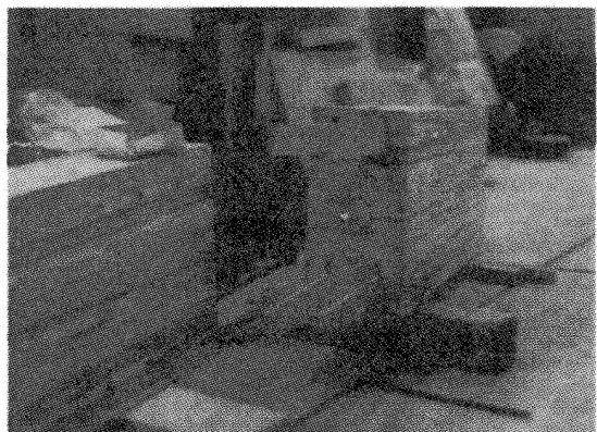
写真一2 ボルトを外した状態の部材連結部
