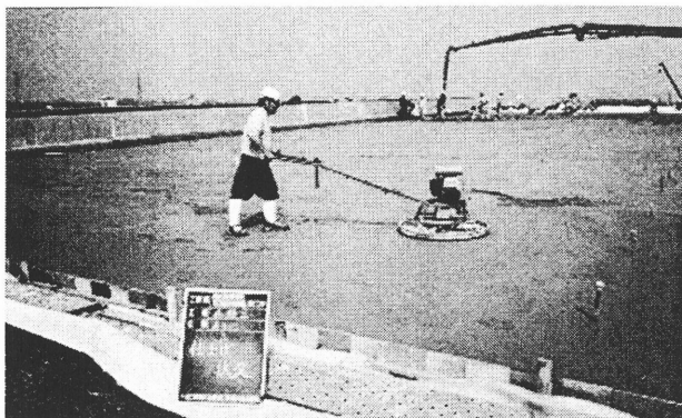
写真-4.5.5 コンクリートの締固め状況
