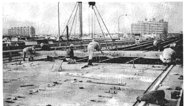
写真-2 新琴似高架橋のプレキャストPC床版架設状況
