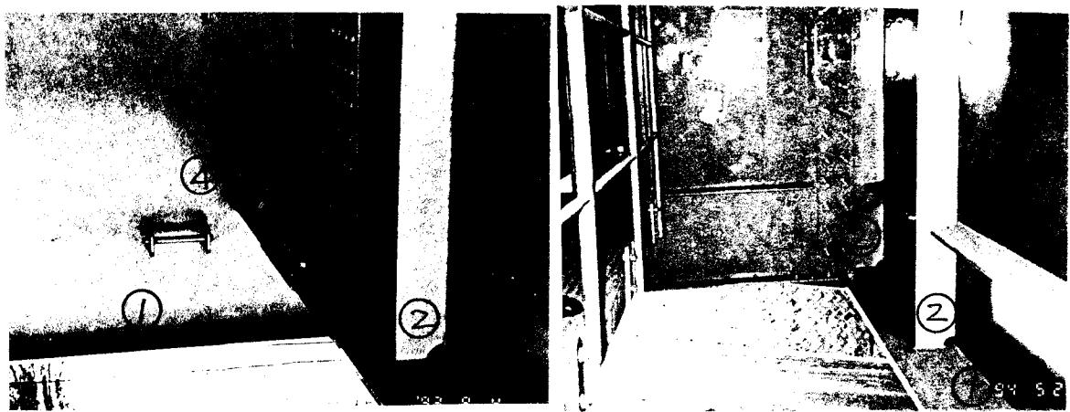
図-9 主桁と横桁の取り合い部（箱桁） 図-10 主桁と横桁の取り合い部（I桁）
