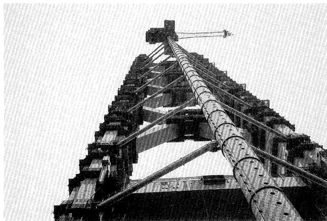
写真-4.2.8 明石海峡大橋の架設クレーン
