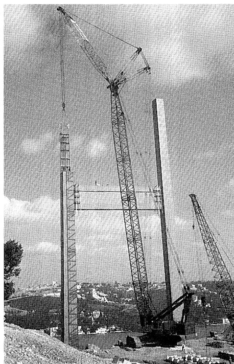
写真-4.2.9 第2ボスボラス橋の架設クレーン
