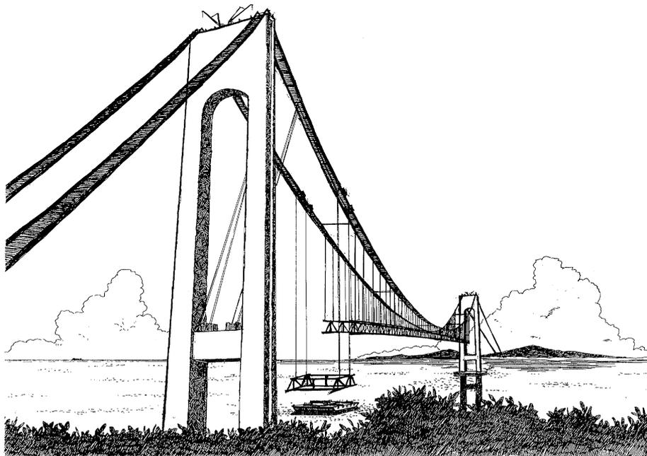
図-4.4.2 Verrazano Narrows 橋の補剛桁の架設
