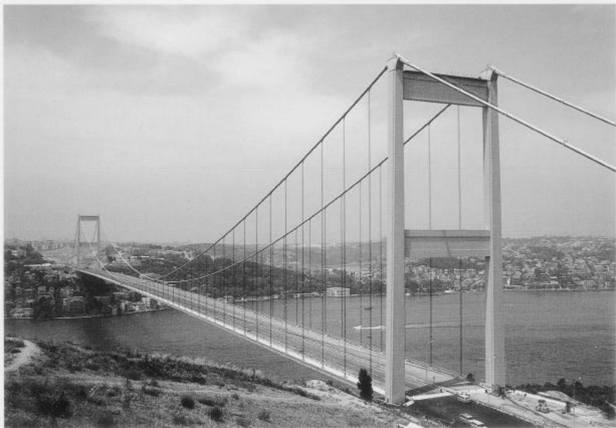
第2 ボスボラス橋 (石川島播磨重工業株提供)
