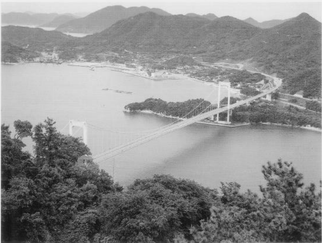
大島大橋（本州四国連絡橋公団提供）
