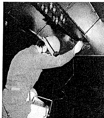
写真-4.6 超音波探傷試験状況
