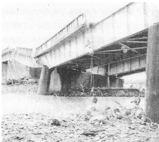
写真-1.19 水害時の橋脚の洗掘による落橋事例
