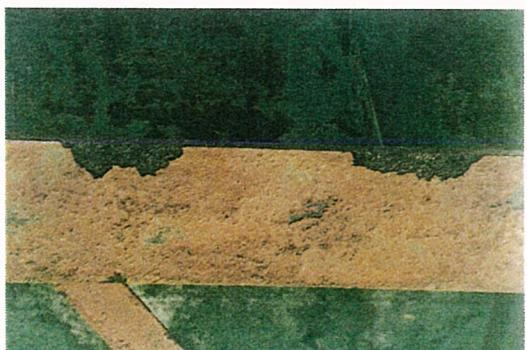
写真-1.13 無塗装耐候性橋梁における層状剥離錆
