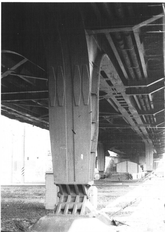
脚と橋梁下面 〈1982年10月，撮影・田島二郎〉
