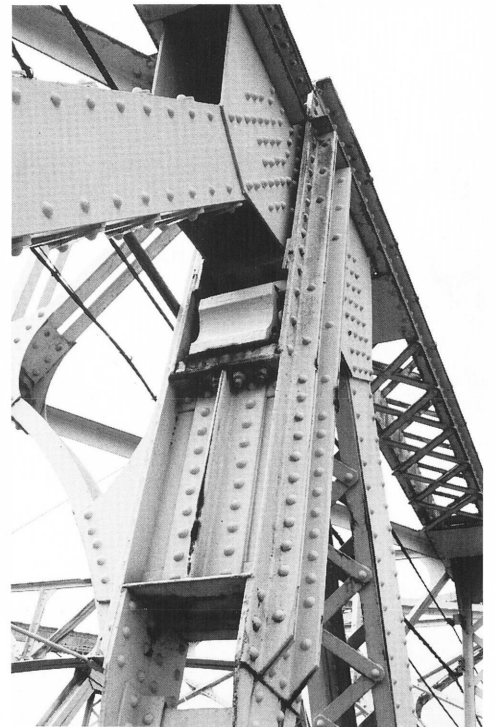
吊径間のヒンジ部構造
