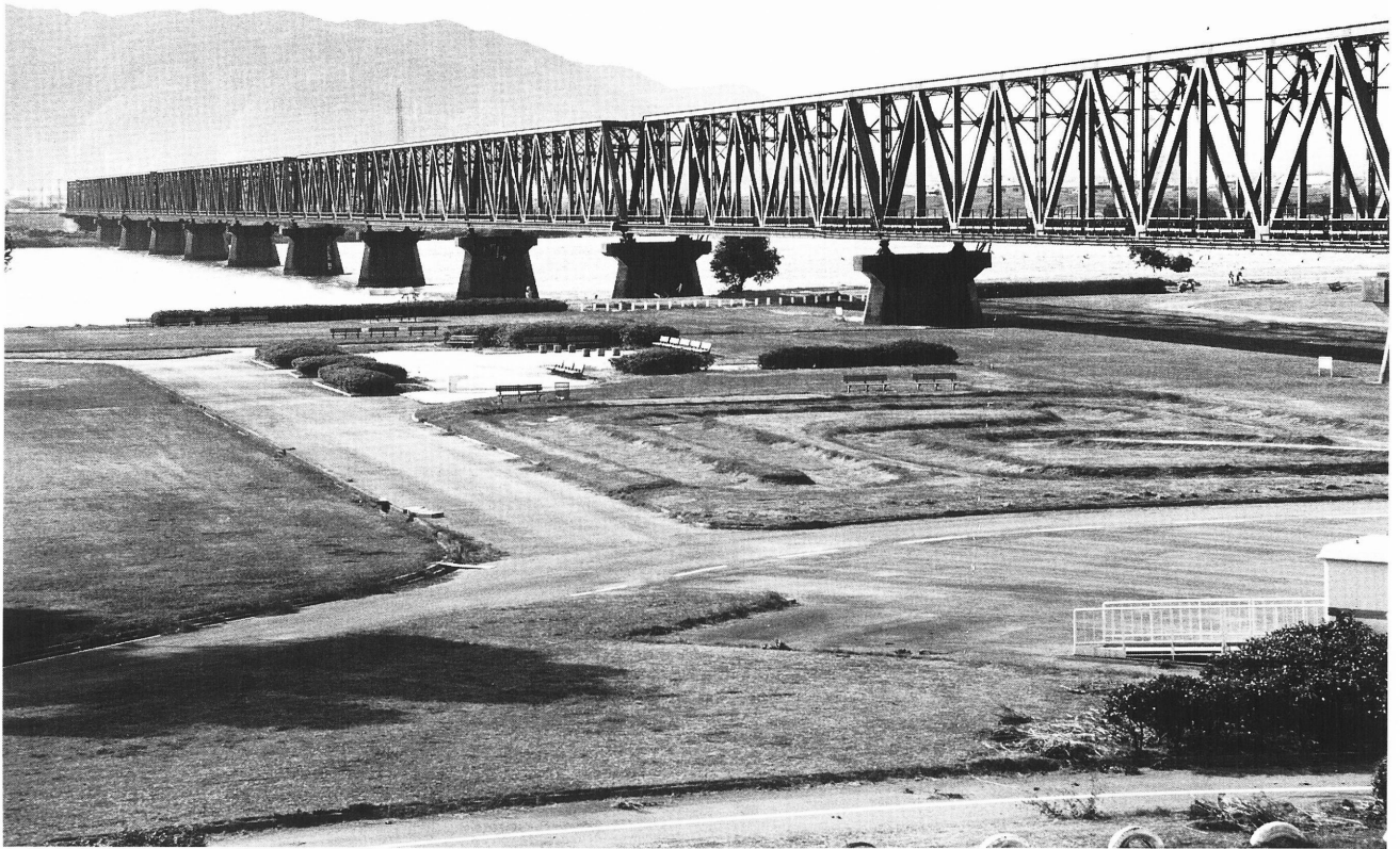
上弦材と下弦材が平行になった直線形状のトラス橋。
