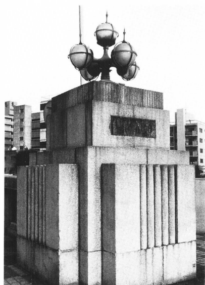
親柱に比べて，現在は小さな橋灯がついている。
