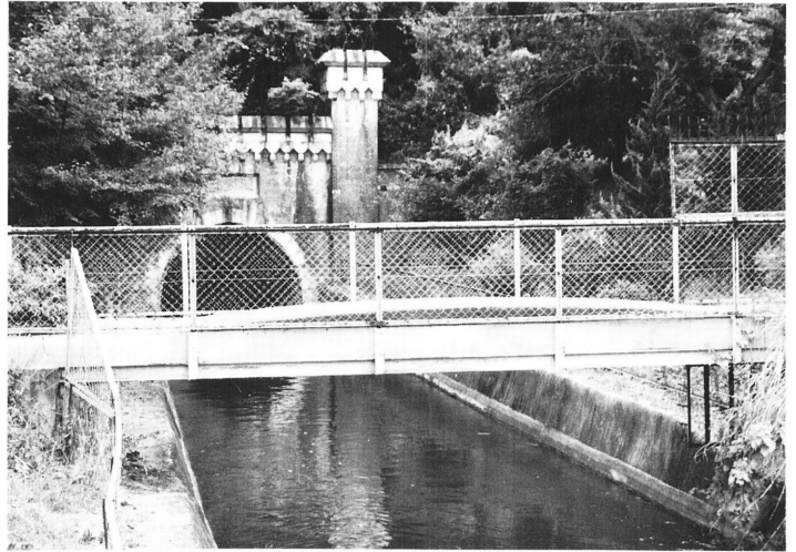
現存最古の鉄筋コンクリート橋（白ノ岡第11号橋）
