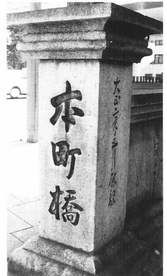
親柱。大正二年五月架設と刻まれている。
