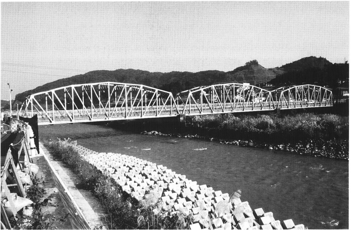
右岸上流側より写す
