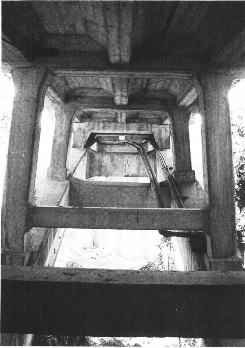
むかし橋面下に交錯していた斜材は、 コンクリート巻立てのとき撤去された。
