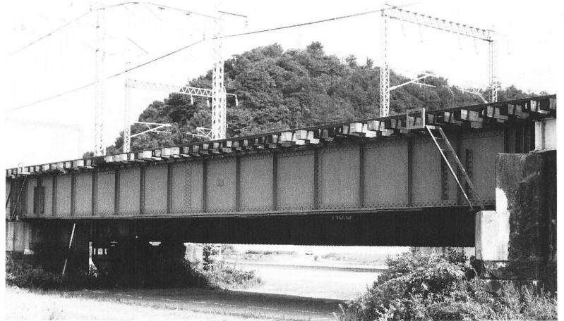
山陽基本形70ftプレートガーダー。後のものに比べると桁高が小さく、 支承は平面支承，モーメントプレートはない。銘板は中央につく。
