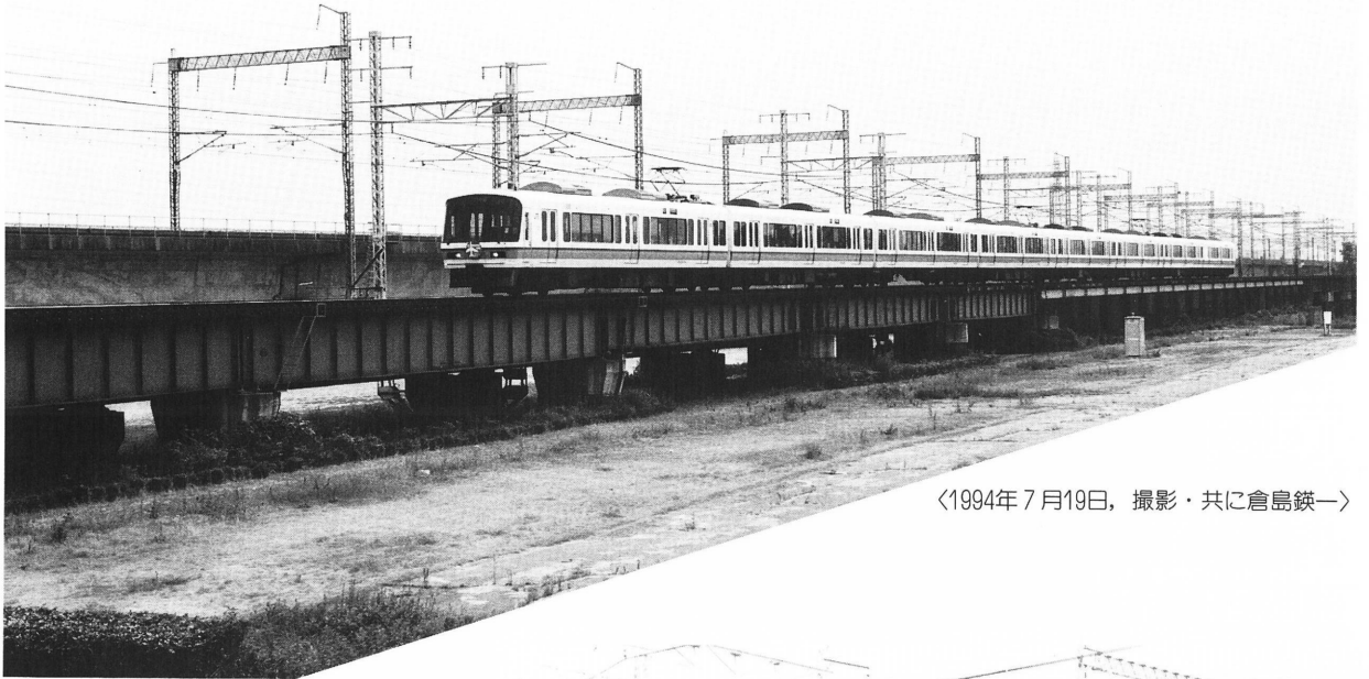
221系電車が渡る山陽本線市川橋梁上り線。 左から3～5連目が山陽基本式。
