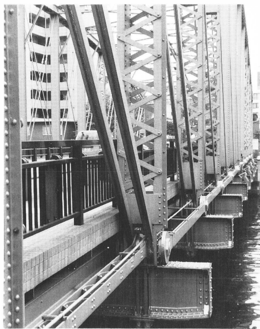
アイバーピン結合のトラスは、いまでは非常に珍しくなった。
